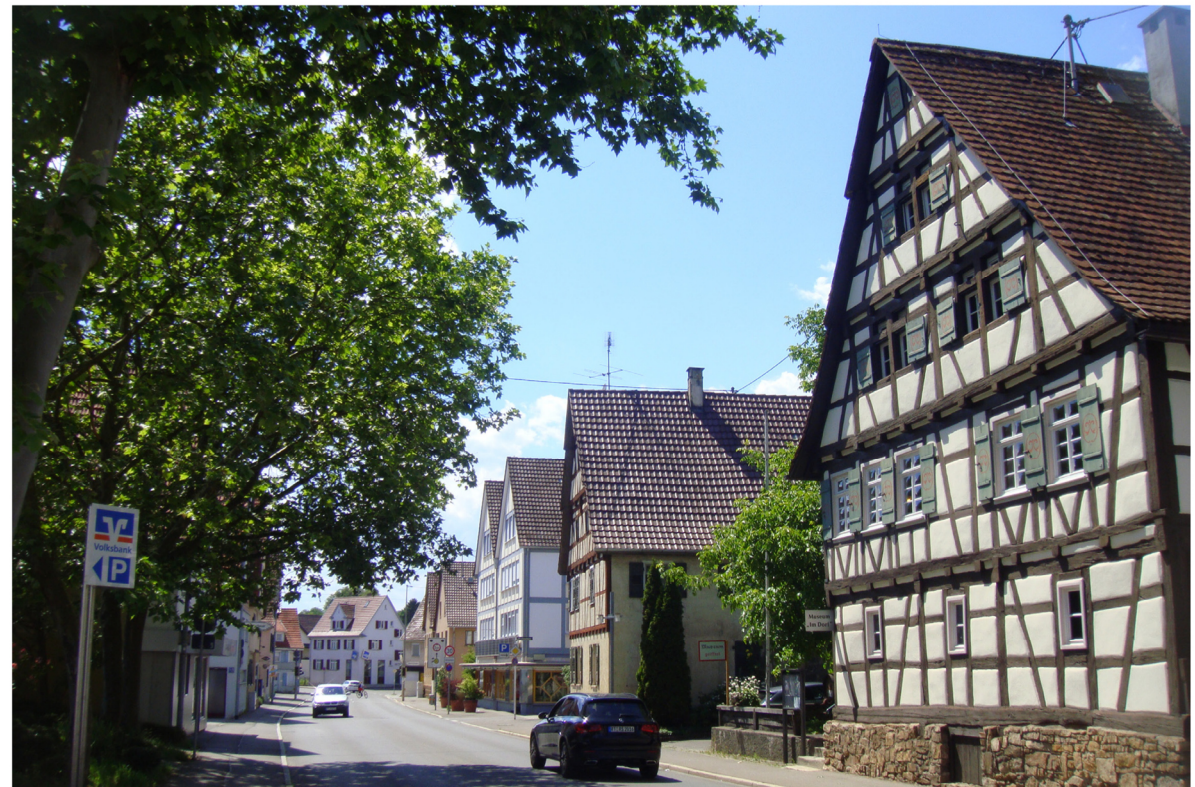
Blick entlang der Straße «Im Dorf»
