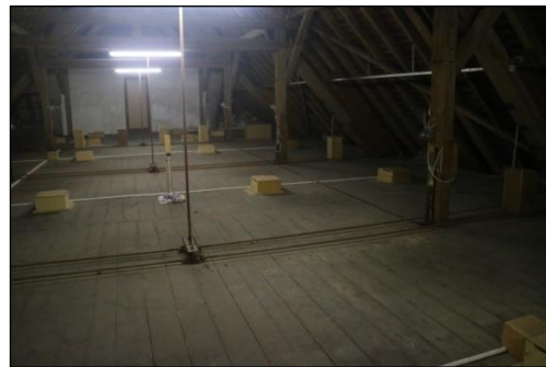
Dachstuhl des Kirchengebäudes (B)
