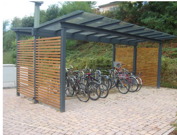
Fahrradparken außen, überdacht (abschließbar / offen)
