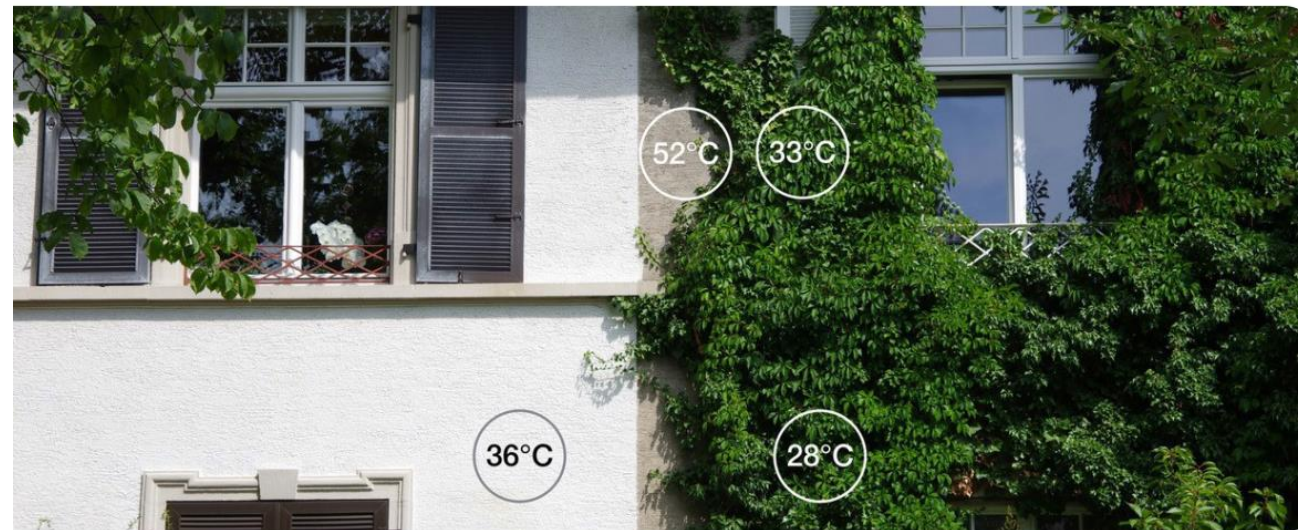
Kühleffekt einer erdgebundenen Fassadenbegrünung (Nicole Pfoser)
