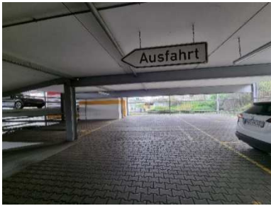
A14: der Bereich in P1
