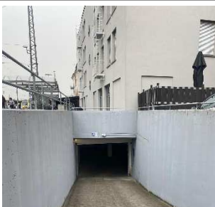
A18: Tiefgarage Bahnhof
